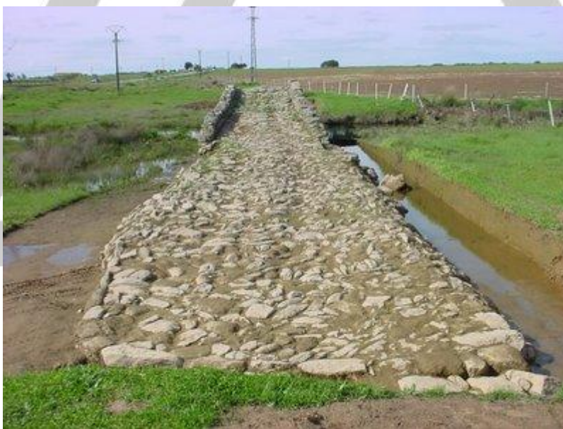
Empedrado moderno con lastras de corneanas en el puente de Santiago de Bencáliz (s. XVIII).
