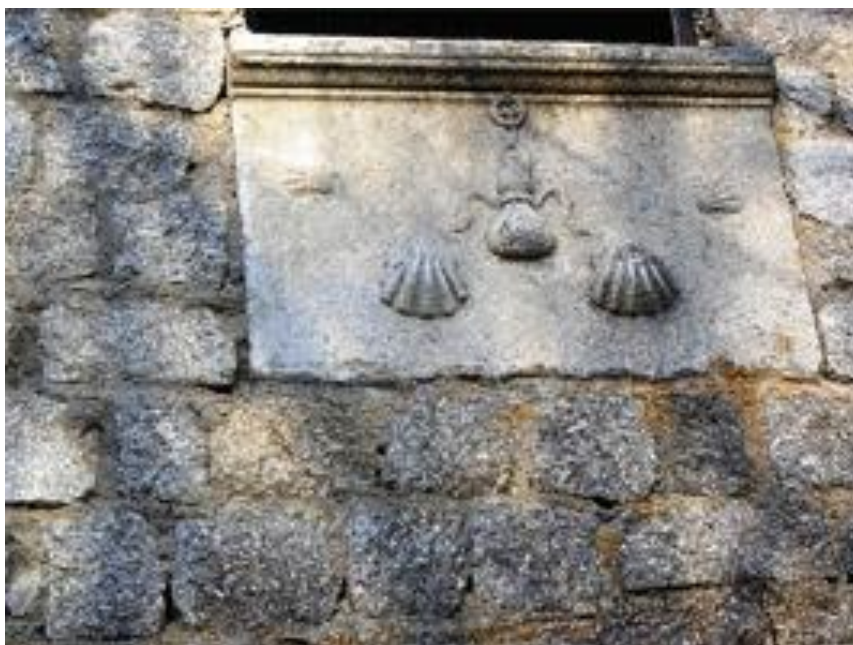
Alfeizar en una de las ventanas de la Fonda
