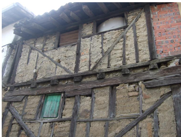
Típica construcción de adobe y madera de castaño de la zona
