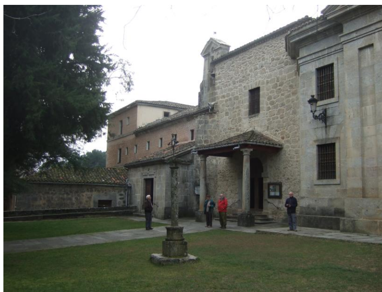
Fachada del convento y de la iglesia de los franciscanos
